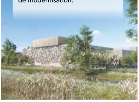
Les esquisses de la station Maera après les travaux de modernisation.
